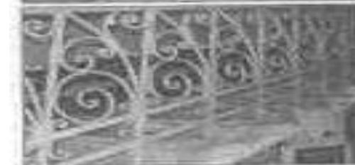
Решетки лестниц 2-го корпуса
